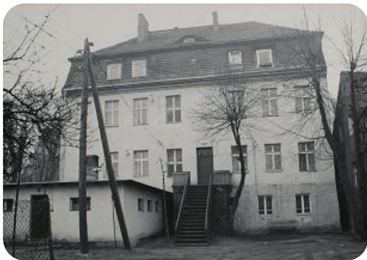
Budynek przy ul. Mennica 6 przed renowacją
