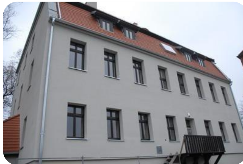
Budynek przy ul. Mennica 6 - Centrum Pracy i Przedsiębiorczości - efekt projektu
