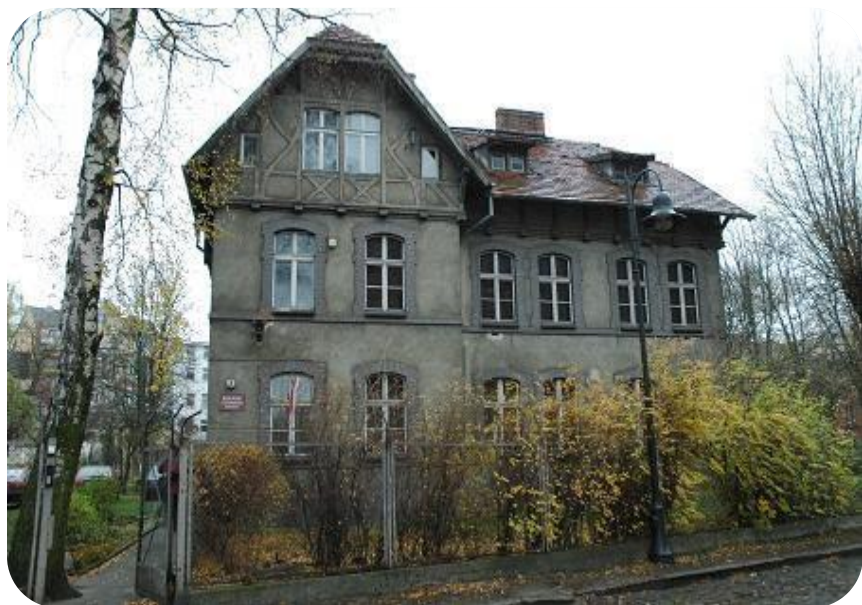
Budynek przy ul. Mennica 7 przed renowacją – rok 2005
