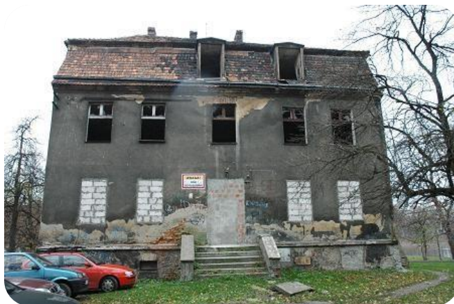
Kamienica przy ul. Mennica 4 przed renowacją – rok 2005
